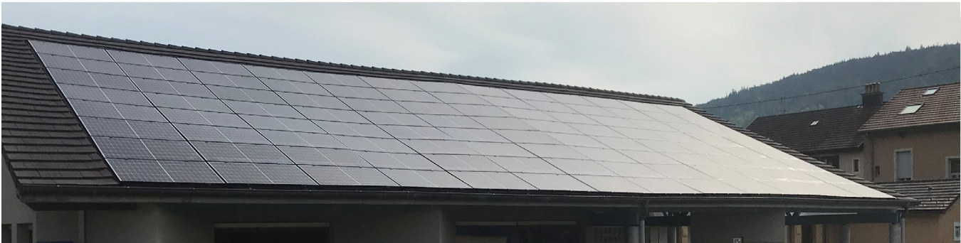
Centrale photovoltaïque de Bellignat.
