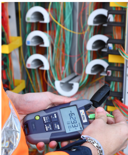
Contrôle de connexion à la fibre optique.
