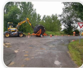
► **Sermoyer** : travaux de câblage de la desserte de fibre optique en aérien sur rehausse d'infrastructure télécom.
