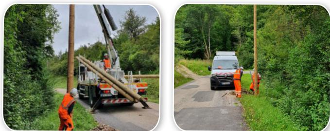
► **Poncin** : réparation des gaines existantes, pour ensuite pouvoir dérouler les câbles de fibre optique (de collecte et de transport) pour l'alimentation des 4 armoires de distribution de la commune.
