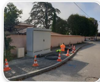
► **Arandas/Conan** : desserte aérienne des communes d'Arandas et Conan. Ici, pose des câbles de fibre optique sur la D104.
