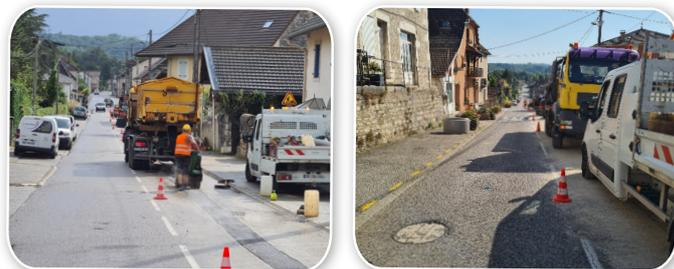
► **Saint-Rambert-en-Bugey** : travaux d'infrastructure souterraine le long de la RD63, entre le bourg et le hameau de Buges. Cette infrastructure se réalise dans le cadre de la mise en place de l'armoire n°3 et servira à la collecte, au transport et à la distribution. L'armoire n°3 a également été posée.
