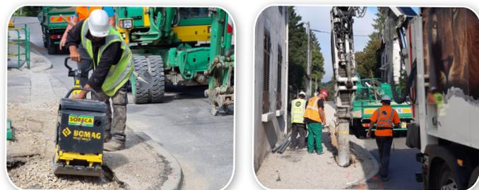
► **Saint-Jean-le-Vieux** : aiguillage des fourreaux avant le tirage des câbles de fibre optique.
