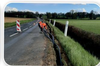
► **Argis** : travaux de génie-civil et plantation de poteaux pour la distribution du réseau de fibre optique.
