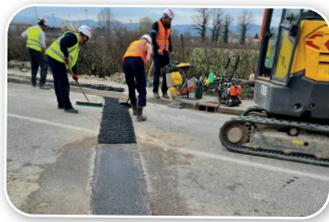
► **Mézériat** : pose de fourreaux PEHD (pour la protection de la fibre optique enterrée) en tranchée mécanisée pour la construction d'une artère souterraine reliant Mézériat, Chaveyriat et Chanoz-Chatenay.
