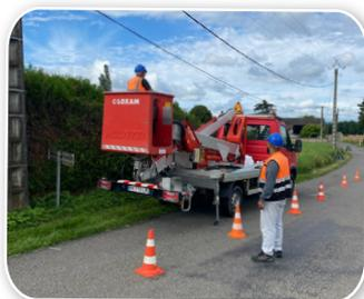
► **Ceignes** : soudure des fibres du câble 288 de fibre optique qui va desservir la commune de La Balme.
