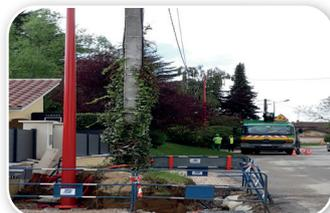
► **Tramoyes** : modernisation des points lumineux et extension de l'éclairage sur l'ensemble de la commune avec 371 points lumineux de 25 à 160W LED.
